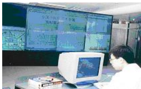
小汤山医院污水余氯实时监测
