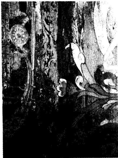
图版 32 银塔北殿西壁空鼓裂缝修复前
