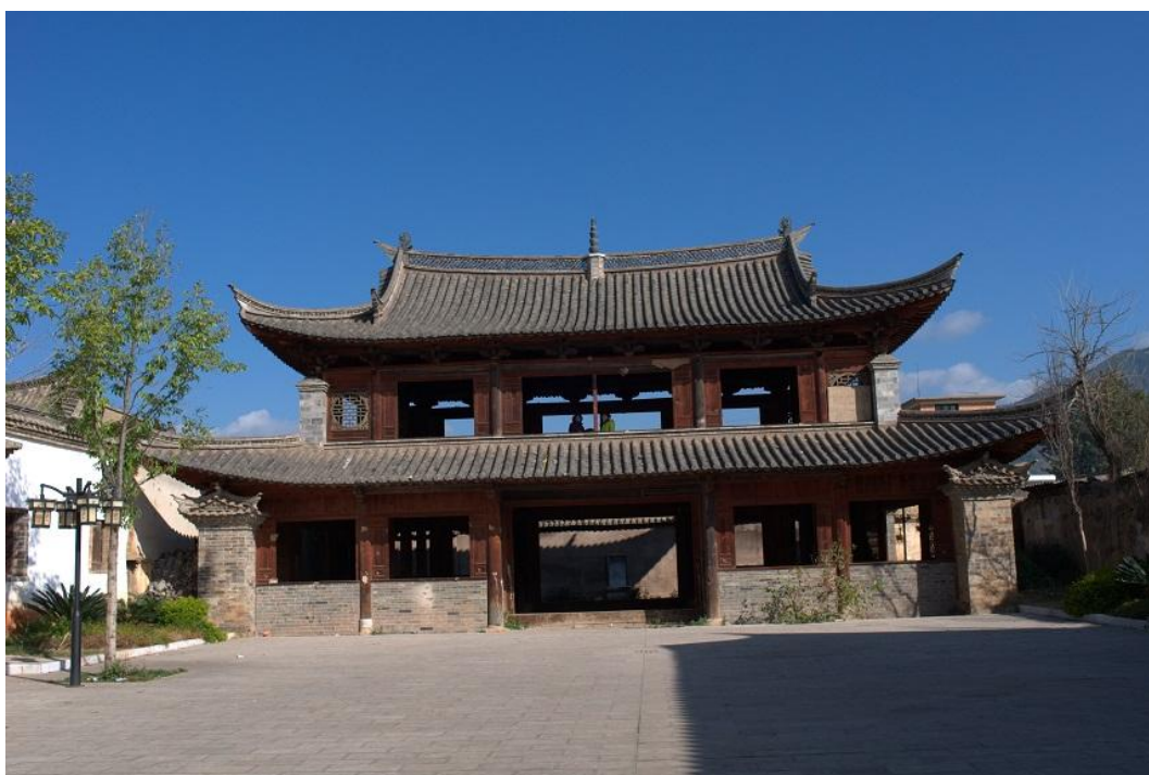
尊经阁修缮前南面全貌
