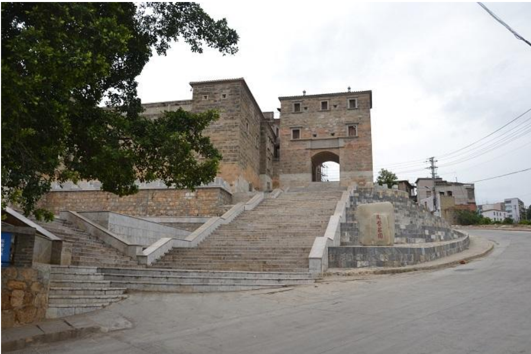
东门楼东立面
