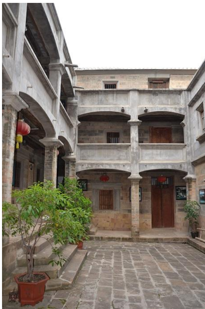
48 号民居建筑砖券柱节
