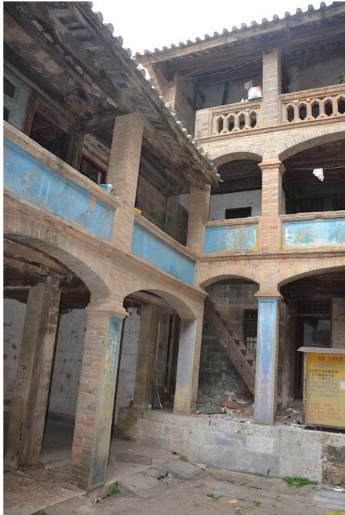
21号民居建筑砖柱砖梁
