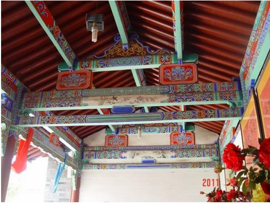
西廊屋前檐及梁架
