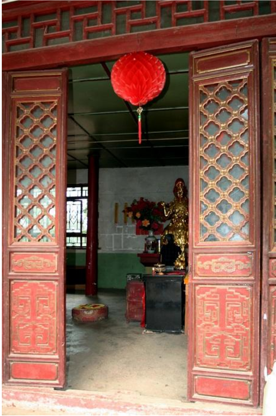
南厢房西次间隔扇门
