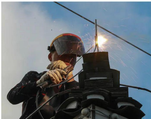
安装防雷设施防患未然
