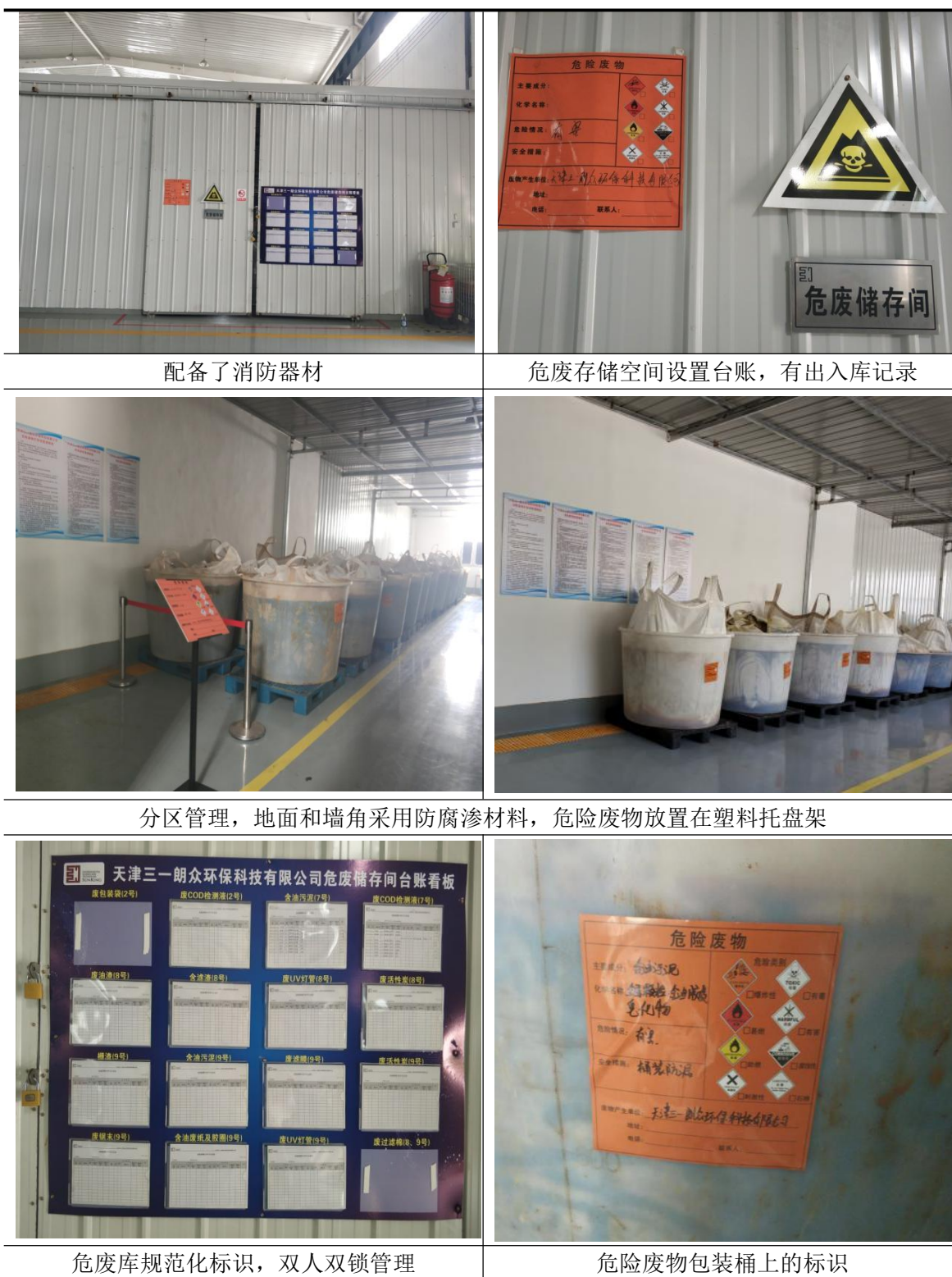
图 4.1-5 危险废物规范管理存放及危废库规范化标识
