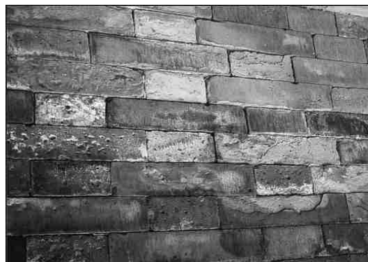
图 4 大雁塔的塔体基座潮湿灰暗(左)及砖的表面风化(右)
