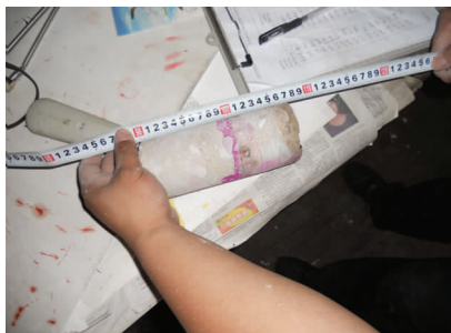
图2 混凝土构件碳化深度过大
