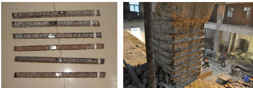
图1 民国钢筋混凝土构件中的方钢
