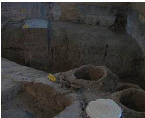
图2 侧壁开裂 Fig. 2 Wall cracking
