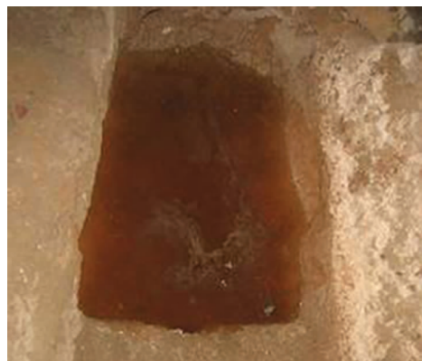
图5 水出露点 Fig.5 Water dew point out
