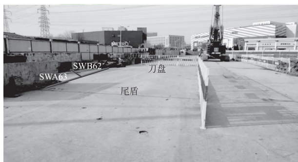
图8 现场地面情况
