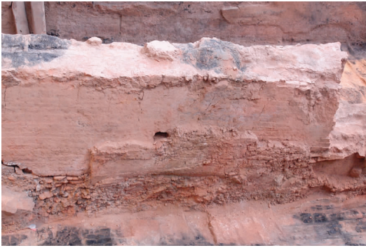
图3 南隔墙南侧夯层
