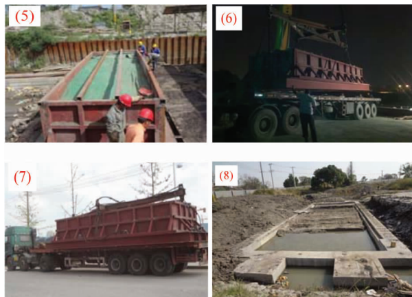
(5) 装箱加固; (6) 吊装; (7) 运输; (8) 切割完毕
