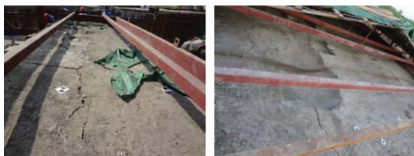
图 13 区块 1 号与 3 号房址土体开裂
