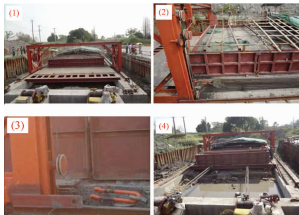
(1) 机械切割准备; (2) 水平切割; (3) 垂直切割; (4) 反向牵引平移
