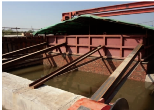
图 11 反力支撑加固
