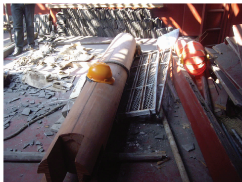
图10 去掉腐烂的后金柱上部用新材料墩接
