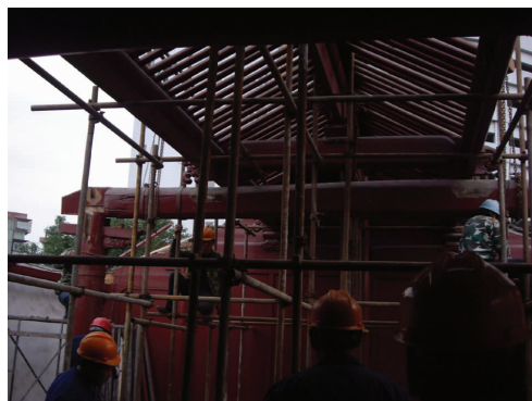
图9 三架梁抬升后,用葫芦把五架梁从金柱上脱离
