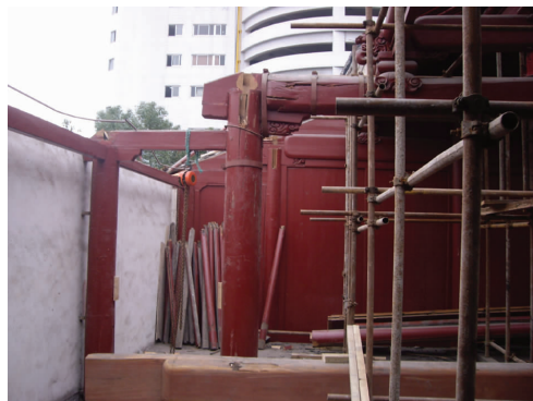
图8 已经移除金檩的五架梁和后金柱
