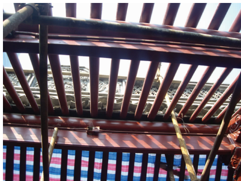
图6 用铁脚手架支撑脊檩金檩及竖直方向夹住上面的屋脊
