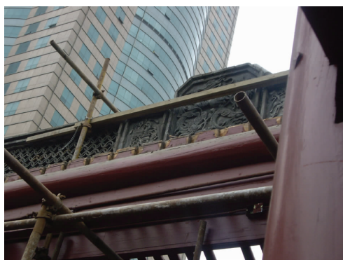
图7 铁脚手架和木条夹住屋脊
