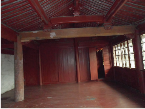
图11 维修后的后殿明间右侧五架梁及后金柱
