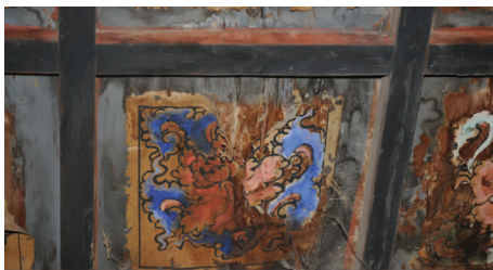
图2 藻井画表面颜料脱落、扩散现象
