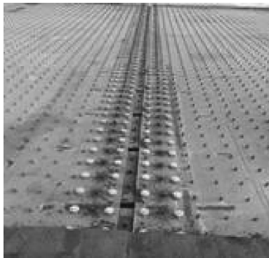
图 32 施工现场桥面连续部位
