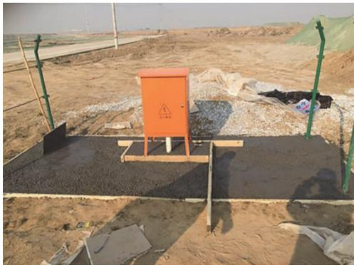
图 5 浇筑混凝土覆盖层
