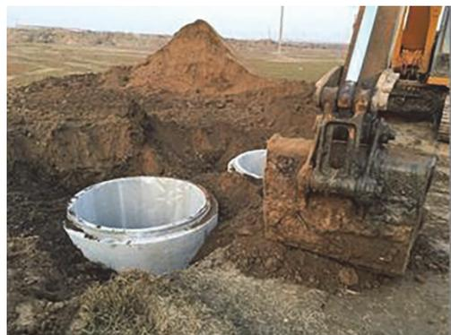
图 3 埋设试验试筒
