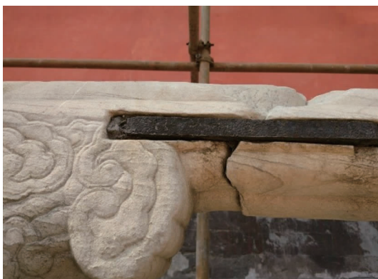
图1 风化的汉白玉石梁(故宫大高玄殿)
