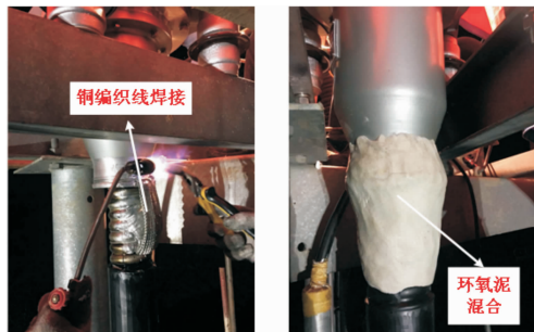
图 13 110 kV 某甲线#C 塔电缆终端安装过程
