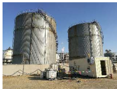
图2 现场应用照片
