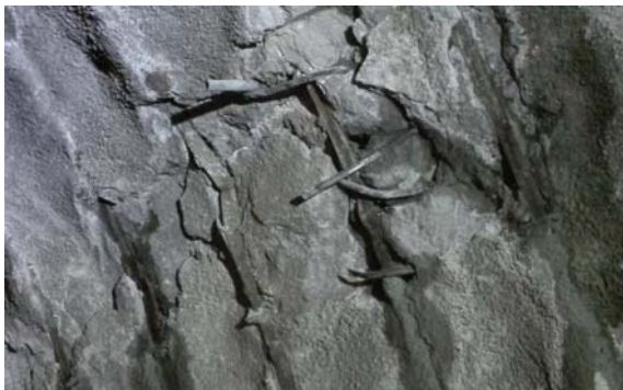
图16 杨家坪隧道三号横洞工区初支破坏
