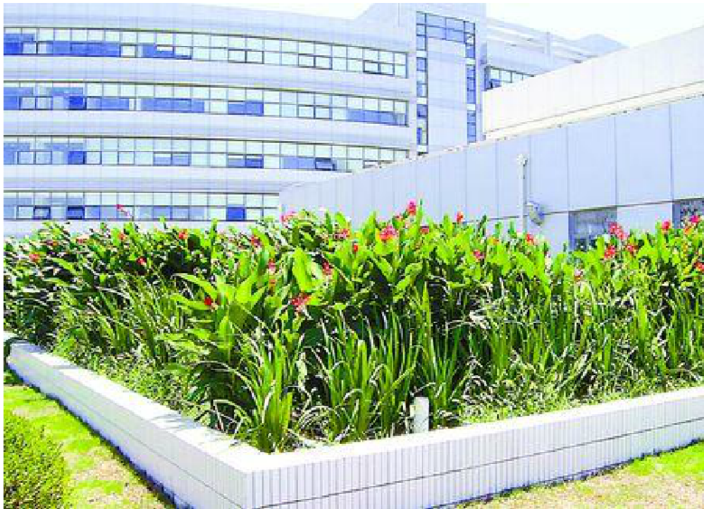
上海洋山深水港区同盛物流园区人工湿地 里的植物“营养”丰富，长得茁壮 150平方米处理30吨/d的生活污水
