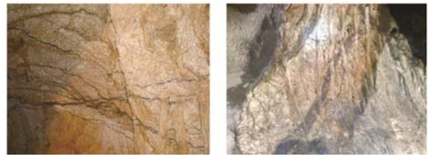
(c) 开挖长度 25 m (d) 开挖长度 35 m
