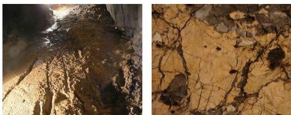
(a) 注浆前 (b) 注浆后
