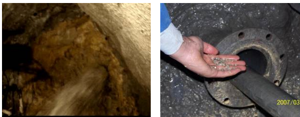
(a) 注浆前 (b) 注浆后
