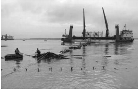
图10 对拉铺设管袋操作
