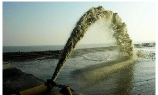
图6 曹妃甸管袋坝围堰吹填造陆
