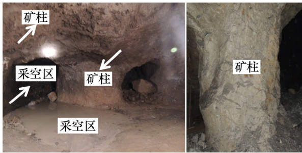
(a) 回采结束采场实景图; (b) 矿柱实景图放大图
