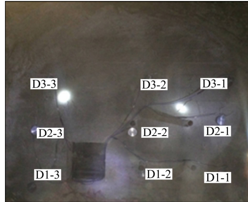
图 4 现场监测仪器布置图
