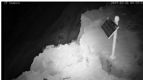
图8 监控视频所拍滑坡开裂过程
