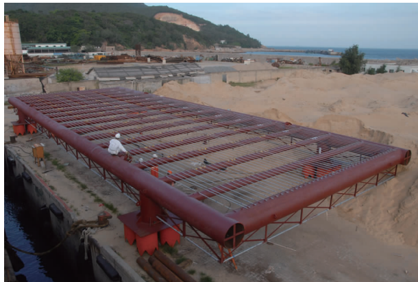
图5 “南澳 I 号”沉船原址保护使用的钢架 (图片来源:“南澳 I 号”水下考古工作队)
