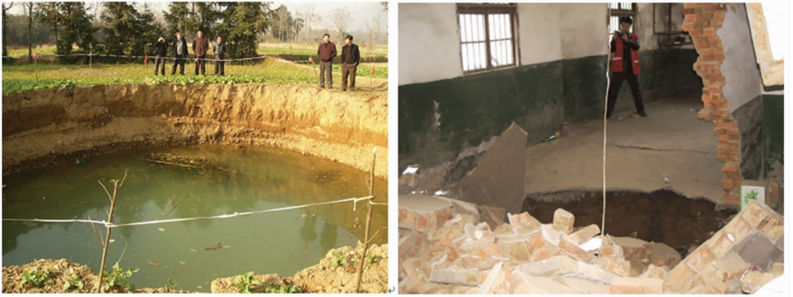
图9 典型塌陷照片
