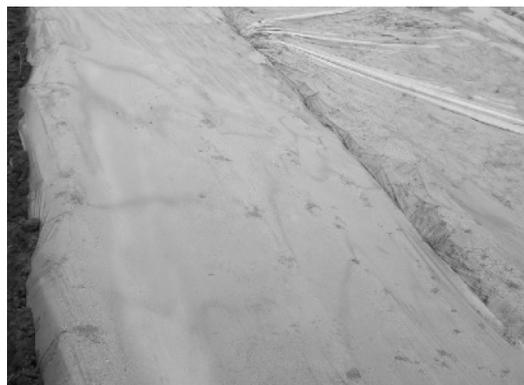
图 1 薄膜相连处采用反埋法
