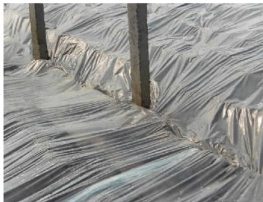
图 2 有立柱温室的薄膜反埋法
