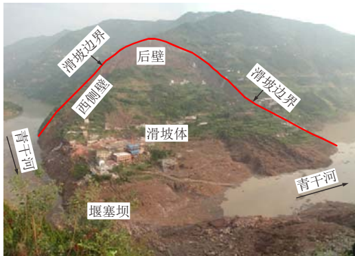
(a) 滑坡全貌
