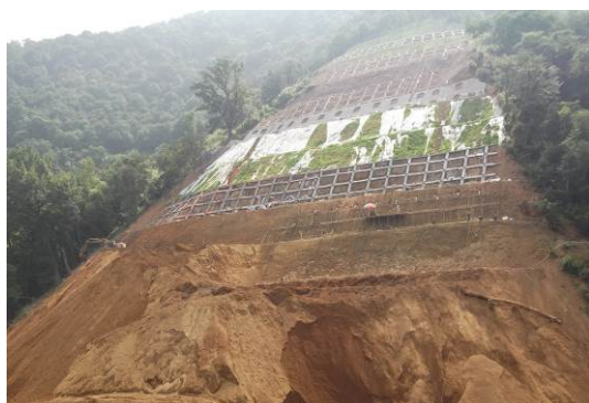
图 10 边坡上部工程施工实景(2011 年 7 月 4 日)
