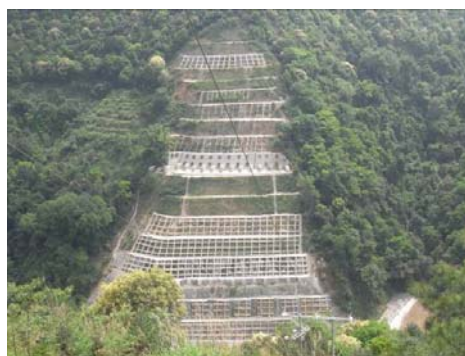
图 13 边坡全部工程结束时的影像(2012 年 4 月 12 日)
