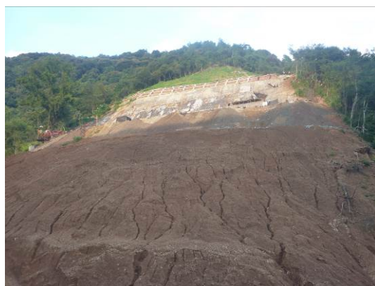
图 6 边坡上部工程施工实景(2010 年 8 月 20 日)
