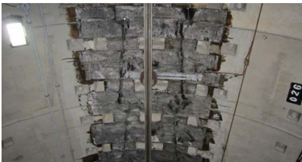
图 2 黏贴 FRP 布加固盾构隧道
