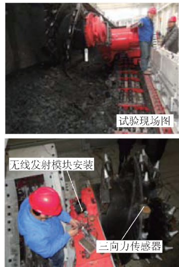
图 5 获取载荷试验现场
