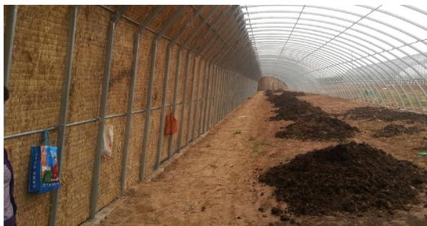
图 2 可移动式日光温室内部结构
