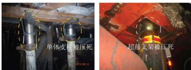
图 7 沿空巷超前支护照片
