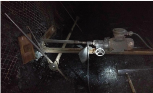
图 6 卸压钻孔现场施工
