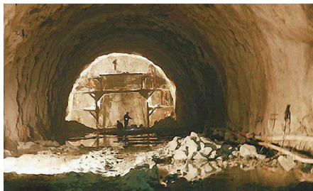
(a) 现场隧道断面
