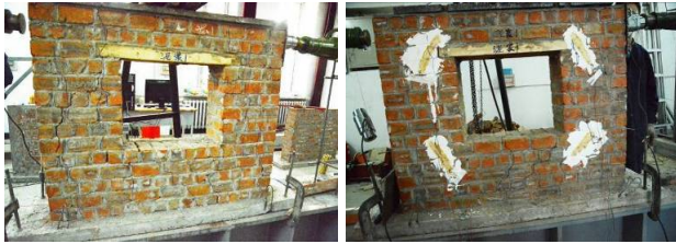
图 2 1-M1 墙体破坏照片 Fig.2 1-M1 wall damage photos
