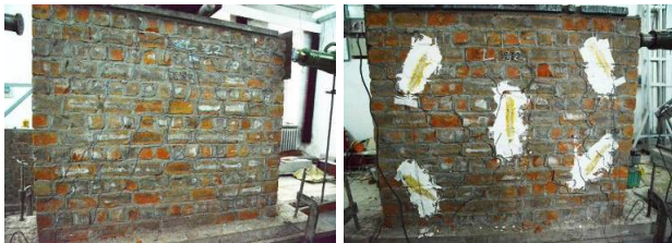
图 4 2-M2 墙体破坏照片 Fig.4 2-M2 wall damage photos
