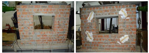
图 6 3-M3-RRBB1 墙体破坏照 Fig.6 3-M3 wall damage photos
