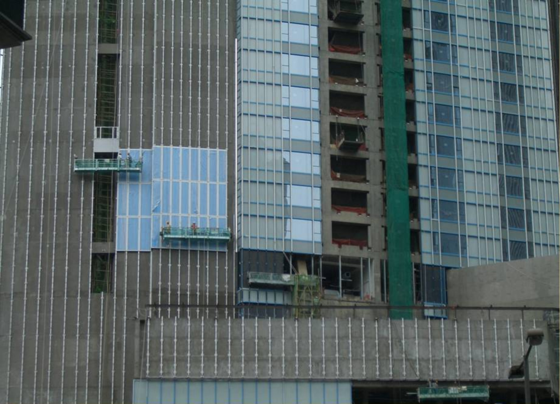
■正在安装幕墙的建筑
