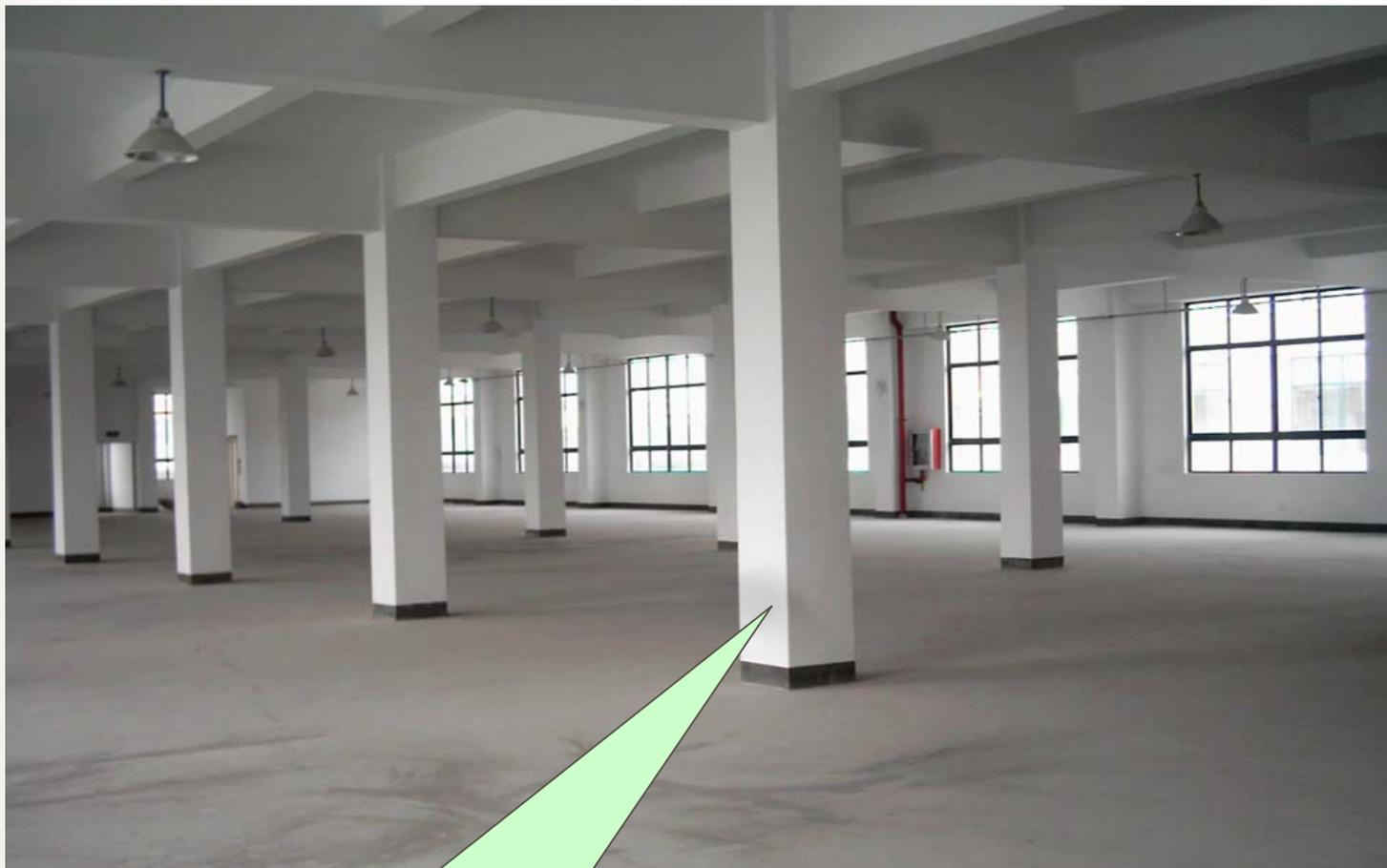
多层钢筋混凝土框架
