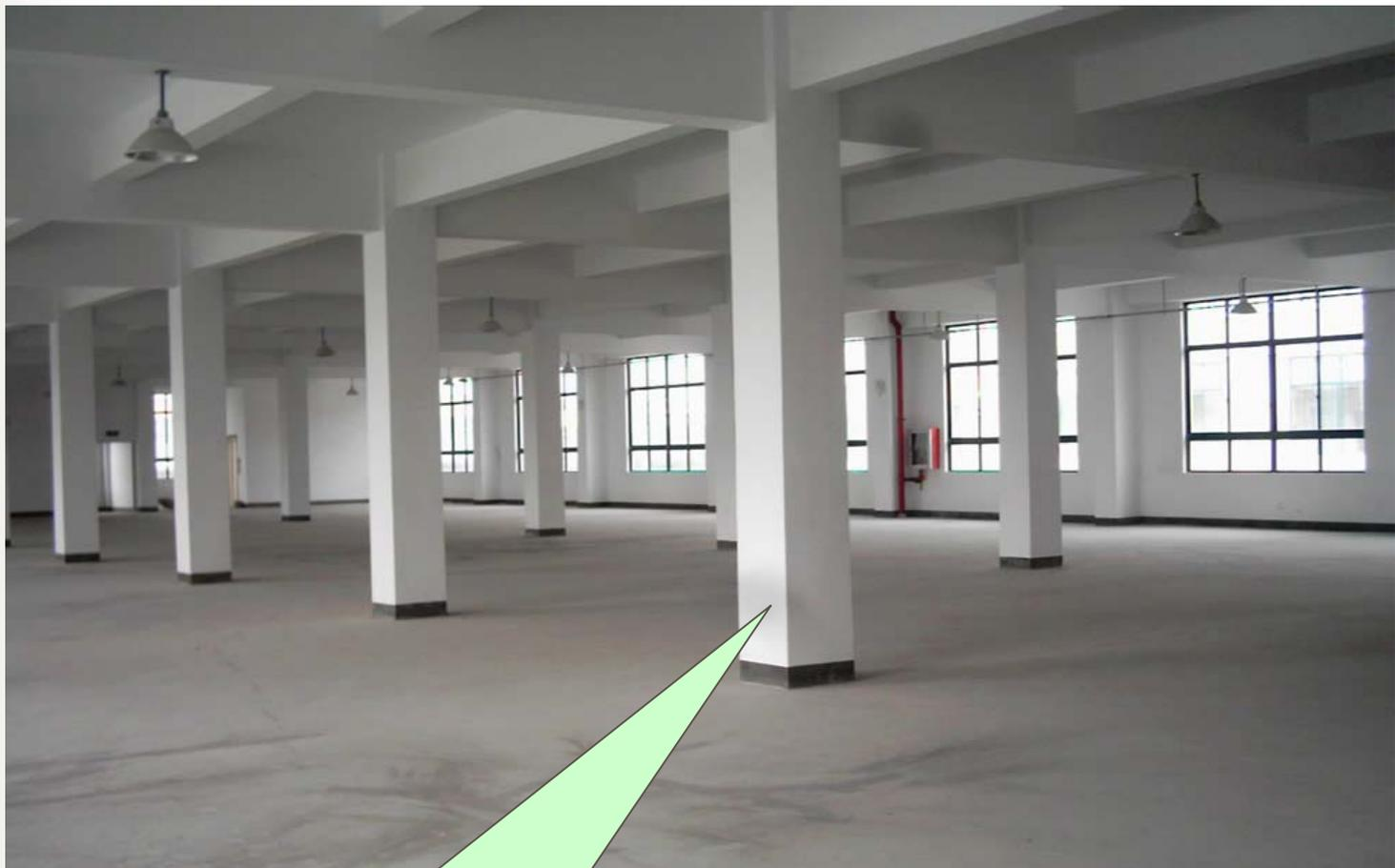
多层钢筋混凝土框架
