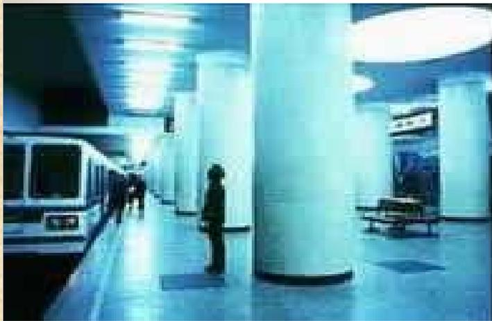
钢管混凝土柱
