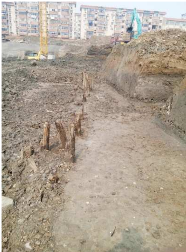
现场挖出的木桩
