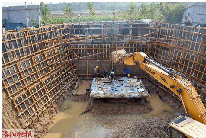
在墓葬底部四周挖一圈排水沟，吊车随后将吊起木箱
