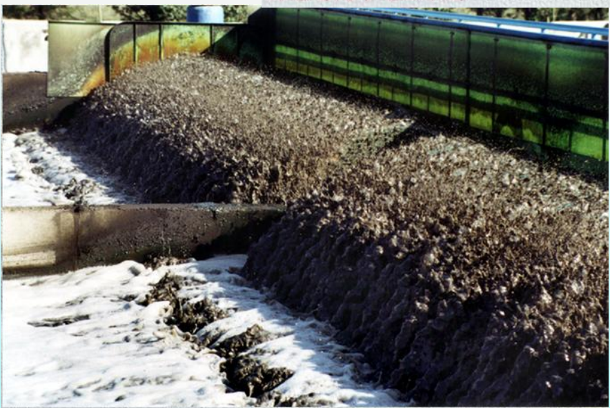
转碟曝气器工作状态 (细节)
