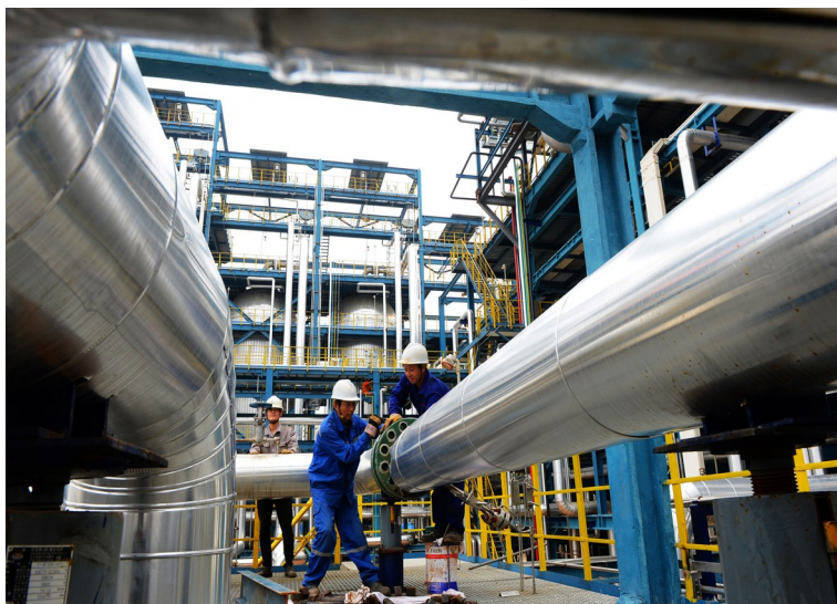
九江石化油品升级工程主体完工
