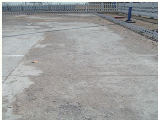
图1 混凝土路面起砂
