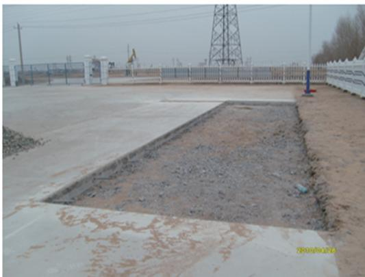
图2 混凝土路面切割后重新施工现场
