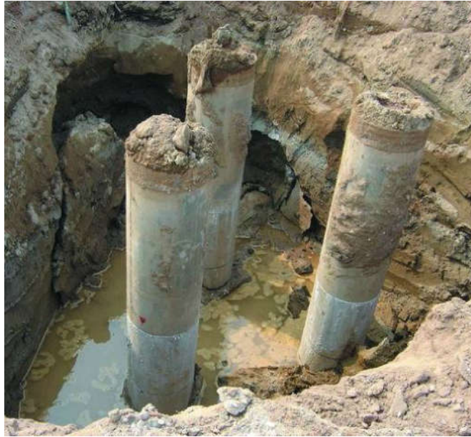
挖后桩头全出来了
