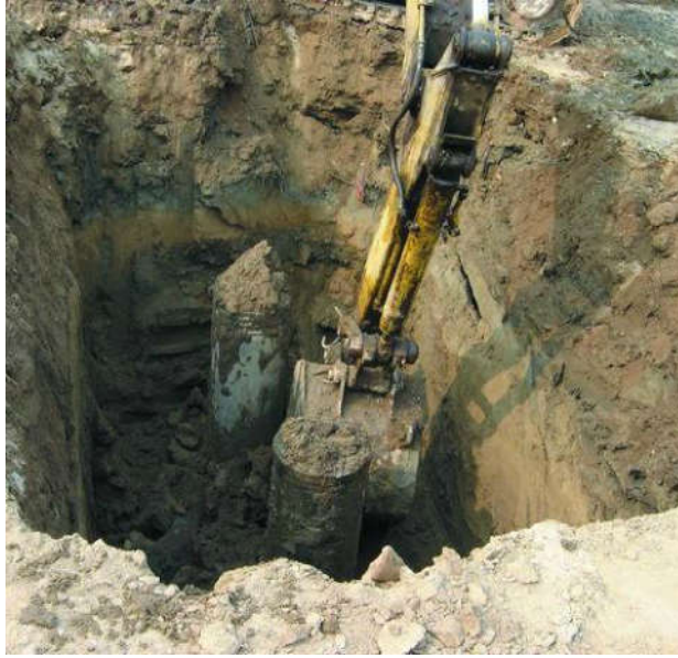
挖土机挖承台坑
