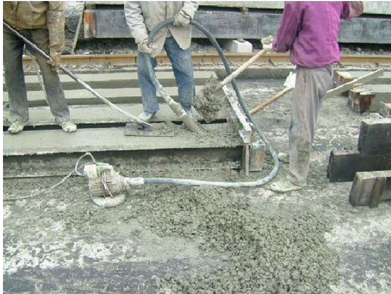
振捣混凝土
