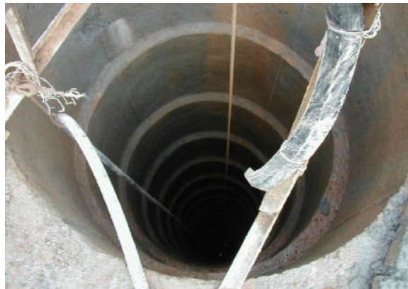
人工挖孔灌注桩
