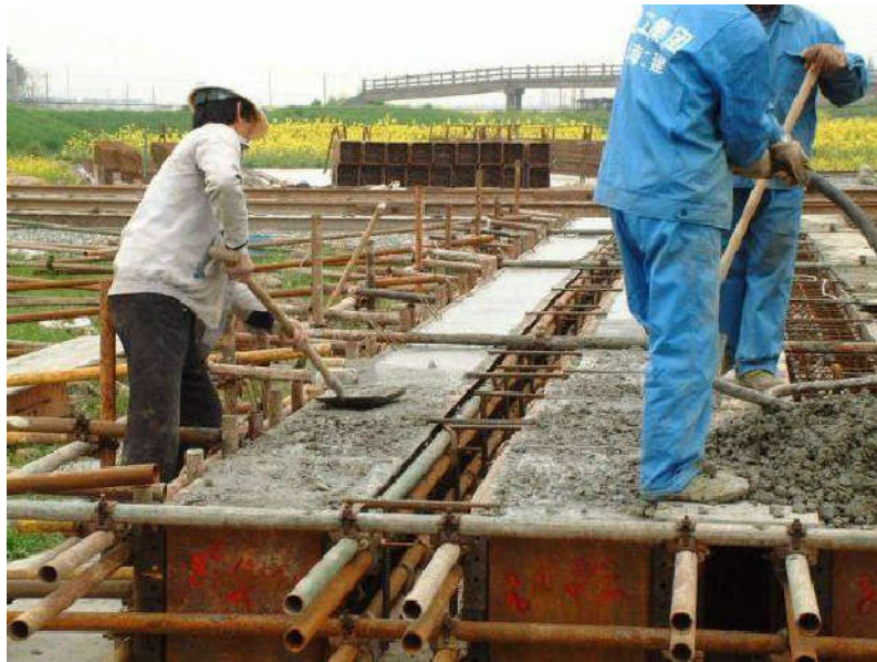
浇筑混凝土
