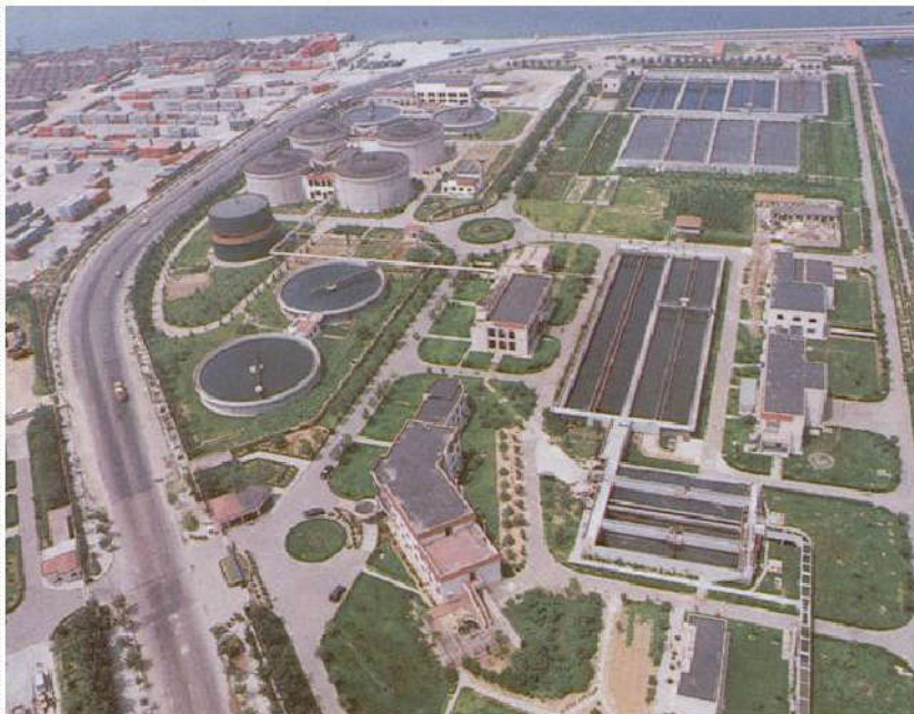
青岛海泊河污水处理厂
